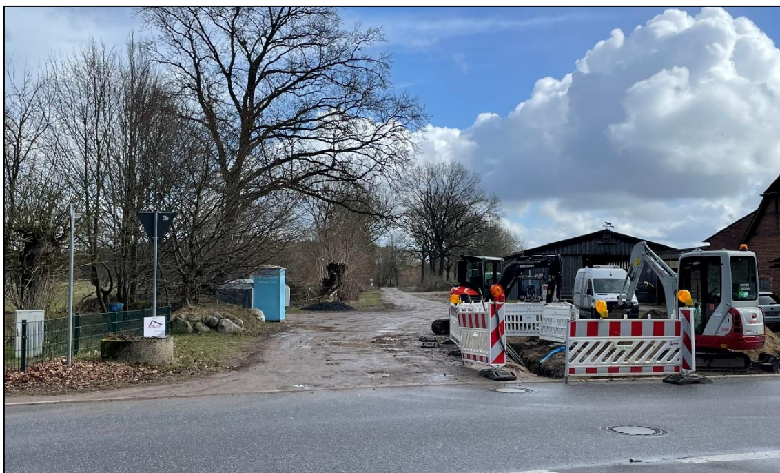
Abb. 8: Straßenansicht der Fläche 2 (rechts) vom Standort Gudower Straße (Hs-Nr. 2) in östliche Richtung blickend (PROKOM Stadtplaner und Ingenieure GmbH)
