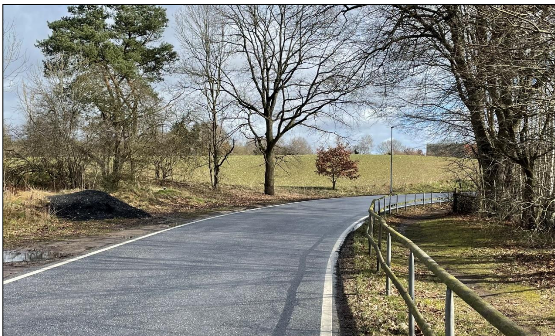
Abb. 7: Straßenansicht der Fläche 1 (links) vom Standort Möllner Straße/Abzweig in Richtung Oldenburger See vor der Fläche 1 in östliche Richtung blickend mit Geländesprung (PROKOM Stadtplaner und Ingenieure GmbH)
